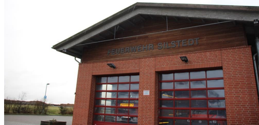
Abbildung 51: Die Feuerwehrrätehäuser in Minsleben und Silstedt (c. 2023; Stadt Wernigerode 2023)
