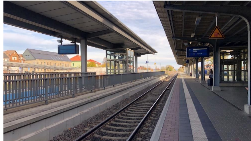
Abbildung 54: Bahnsteig am Hauptbahnhof (cima 2023)
